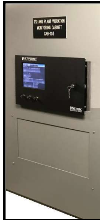
Рисунок 3-8) VC-8000 заменяет рэк 3300 (такой же вырез).
