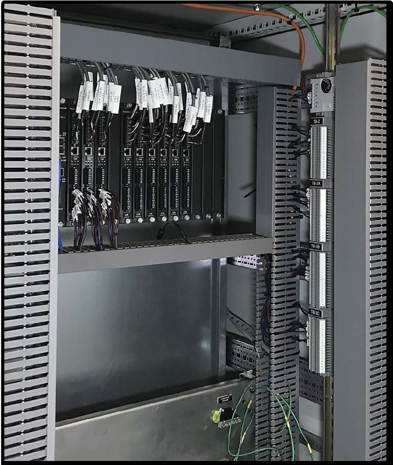
Рисунок Лучшая Практика по VC-8000. Установка 16-слотового рэка, монтаж на стенку на подпанель
